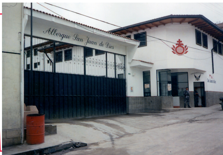
Entrada al nuevo Albergue San Juan de Dios de Quito.
