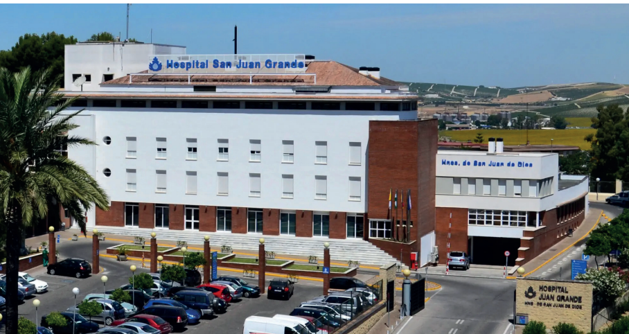
Hospital San Juan Grande, Jerez de la Frontera.
